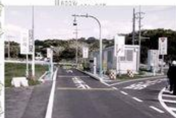
スマートIC 機器標準化/電気設備設計/施工監理
