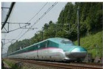
東北新幹線 盛岡～新青森 電気設備設計/施工監理
