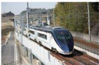
成田高速鉄道 印旛日本医大～成田湯川 電気設備設計/施工監理
