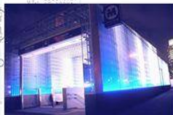
横浜高速鉄道みなとみらい21線 電気設備設計/施工監理
