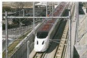
九州新幹線 博多～鹿児島中央 電気設備設計/施工監理
