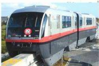
沖縄都市モノレール線 調査/電気設備設計/施工監理
